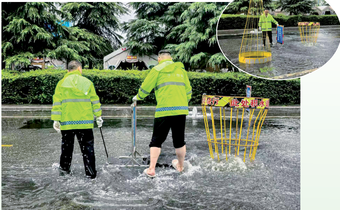
昨日下午,我市迎来一波短时强降水,中心城区部分路段瞬间出现积水。为保障市民安全出行,市城市管理部门的工作人员冒雨疏通管道并设置警示牌。气象部门提醒,未来几天,短时强降水仍有可能出现在我市,请做好防御工作。
