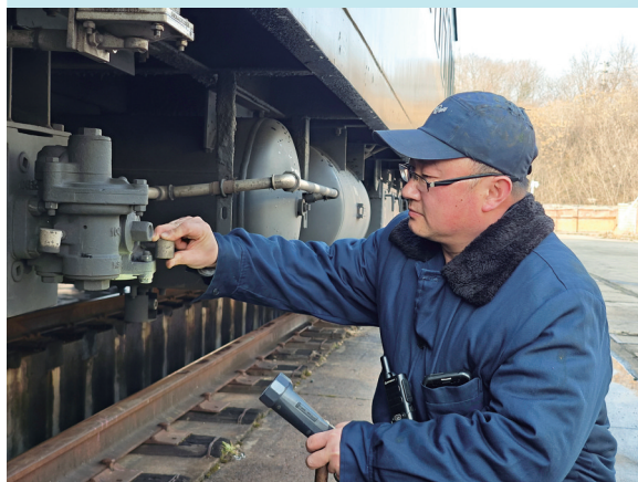
2月10日,铁路武昌客车车辆段面对临客整备任务量显著增加的情况,统筹协调人力资源,从检修车间抽调骨干力量支援运用车间,有效缓解春运期间运用一线检修压力,确保临客列车按时保质投入运营。图为该段信阳运用车间检车员郭锐在检查轮对装置。
