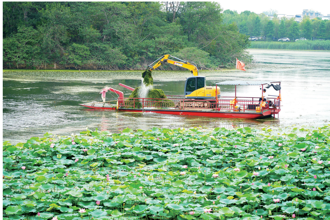
9月4日,针对夏秋季湖面水草过快生长现象,淮滨县东湖管理部门积极组织工作人员用船只和小型挖掘机对水草进行打捞清理,确保湖清水畅。图为打捞水草现场。 王长江 摄
