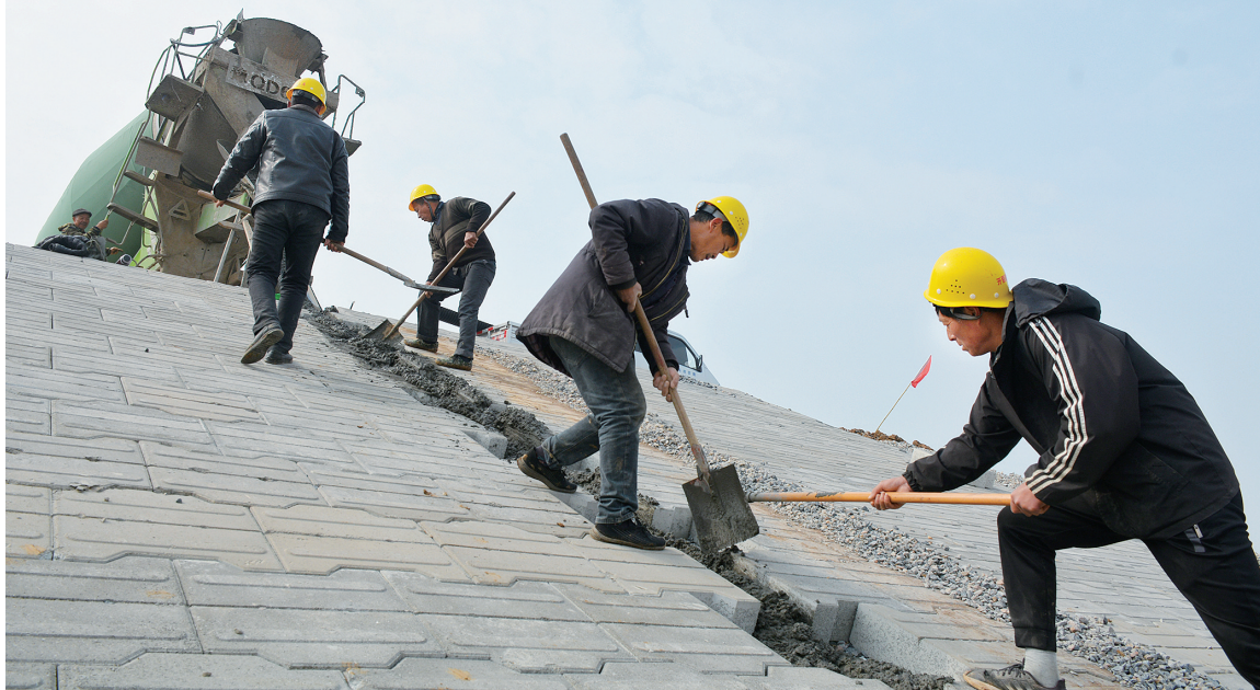
春暖花开时节,息县汪湖水库改造治理工程进入收尾阶段,这座控制流域面积405平方公里的水库将在今年五一前以新的面貌示人。图为3月13日,工人在硬化水库大坝护坡。 本报记者 马童 摄
