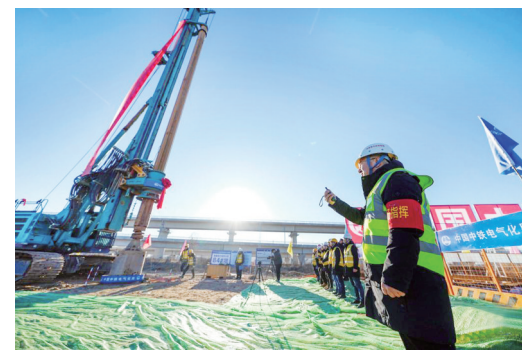
图为建设现场。新华社记者牟宇摄
