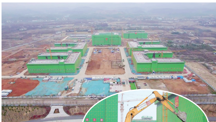
项目施工现场
