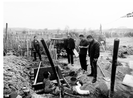
为扎实推进美丽乡村建设,深入推进农村“厕所革命”,进一步改善农村人居环境,罗山县山店乡将“户厕改造”工作作为一项重要的民生实事来抓,补齐生态文明短板,推动乡村振兴。图为日前该乡“改厕”工作施工现场。 罗轩 摄
