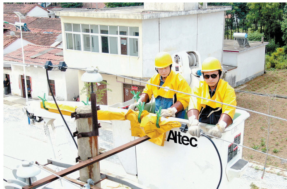
为做好迎峰度夏期间电力可靠供应,持续优化营商环境,潢川县供电公司加大电网设备巡查力度,充分发挥带电作业灵活、便捷的特点,最大限度减少配电线路和台区停电次数,提高电网运行可靠性,为当地经济社会持续发展注入绿色动能。图为电力工人正在检修线路。刘力娜 杨君 摄
