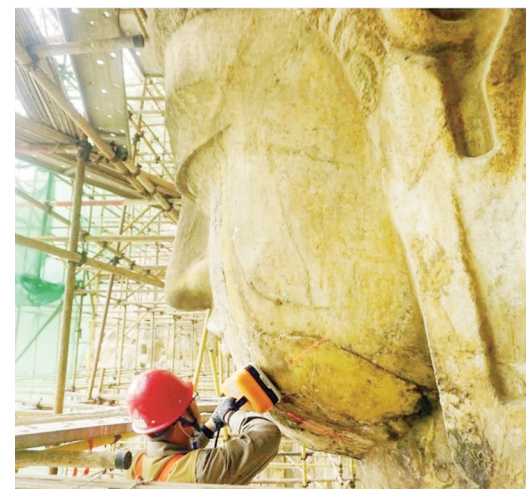
考古人员在对龙门石窟奉先寺卢舍那大佛面部进行检测。(文图均据新华社)
