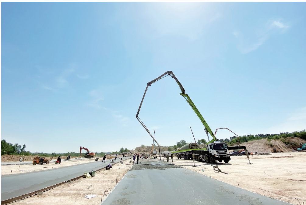
施工现场 本报记者 李凯 摄
