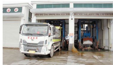
改造后的平桥区龙江东路生活垃圾中转站
