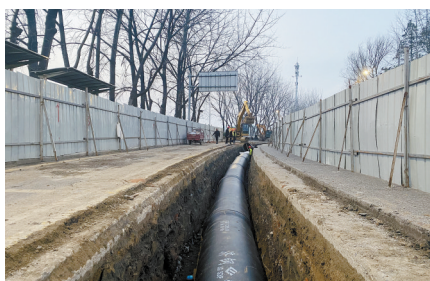
技术人员正在升级改造给水管网
