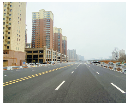
已建成通车的新二十街中段主干道
