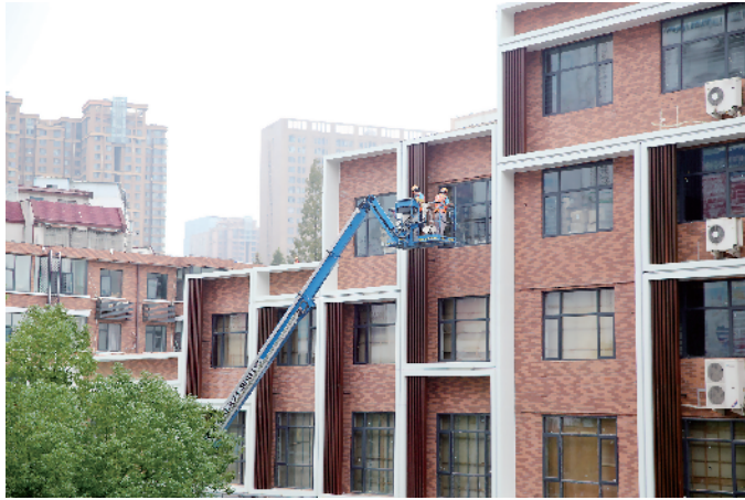
胜利路步行街核心商圈综合改造提升项目施工现场
