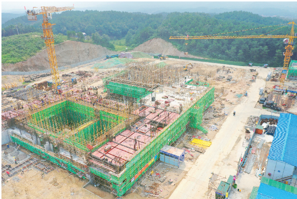
商城县静脉产业园施工现场 曹良刚 摄
