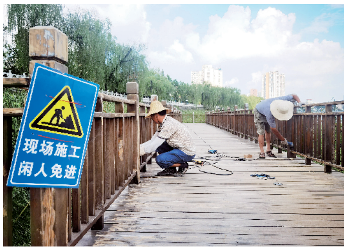
施工人员在工作中 本报记者 张方志 摄
