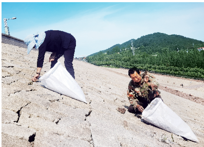
工人正在南湾大坝背水坡上除草 本报记者 张方志 摄
