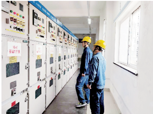
日前,我市遭遇强对流天气突袭,伴有短时冰雹、强降雨、大风。国网信阳供电公司迅速行动,全力开展极端天气下的设备巡视检查与抢修恢复供电工作。 韩奇航 摄
