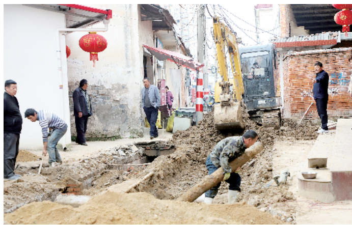
4月6日,在商城县赤城街道三里桥社区朝阳小区老旧小区改造现场,机器轰鸣,施工队正将原路面稀泥挖走,重新铺上沙子。据了解,改造工程完成后,该小区面貌将焕然一新。曹良刚 何世伦 摄
