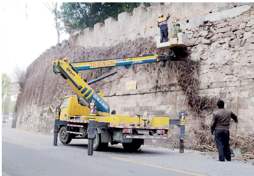
工作人员清理古城墙上的枯树杂草 冷鹏摄
