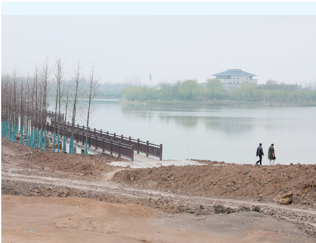
2月27日,淮滨县东西湖改建工程进展顺利,景观道、栈道已初步成形,道路及各项景点正在紧张有序地进行。图为施工现场一角。 王长江 摄
