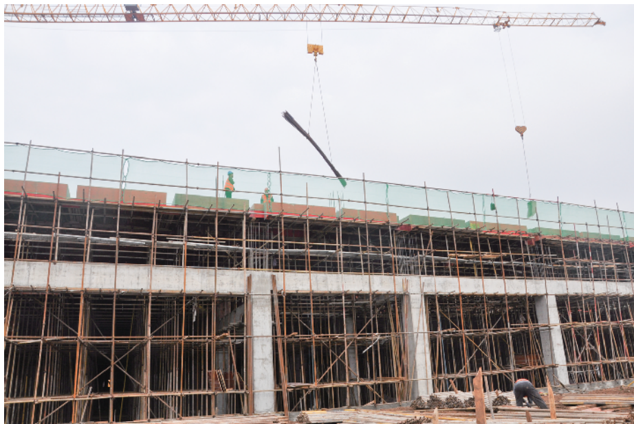
施工现场 本报记者 马保群 摄
