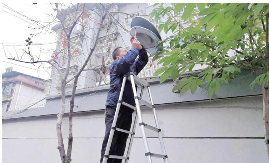
连日来,浉河区湖东街道联合市政工作人员针对背街小巷以及小区路灯开展专项整治,排查路灯安装及亮灯情况。对发现不亮的路灯及时进行维修,保证了路灯设施完好运行,照亮居民回家路。图为工作人员对损坏的路灯进行检修。 本报记者 李倩 摄
