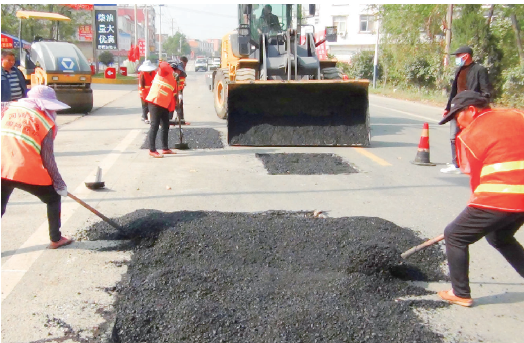
10月30日,公路养护工在S337省道进行养护施工。连日来,固始县公路事业发展中心坚持“以人为本、以车为本”安全指导思想,积极组织县畅达公路养护工程有限公司干部职工抢天夺时,对全县210公里国道省道普通干线公里进行全面维护养护,确保辖区道路安全畅通。 高晋新 叶文生 摄
