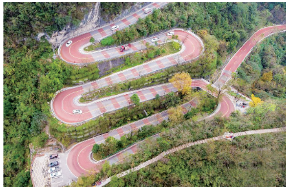
这是10月28日在湖南省吉首市矮寨镇拍摄的盘山公路矮寨盘山公路位于湖南省湘西土家族苗族自治州吉首市矮寨镇。经过靓化提升的矮寨盘山公路,在青山绿树的掩映下,形成山间一道美丽的风景。
