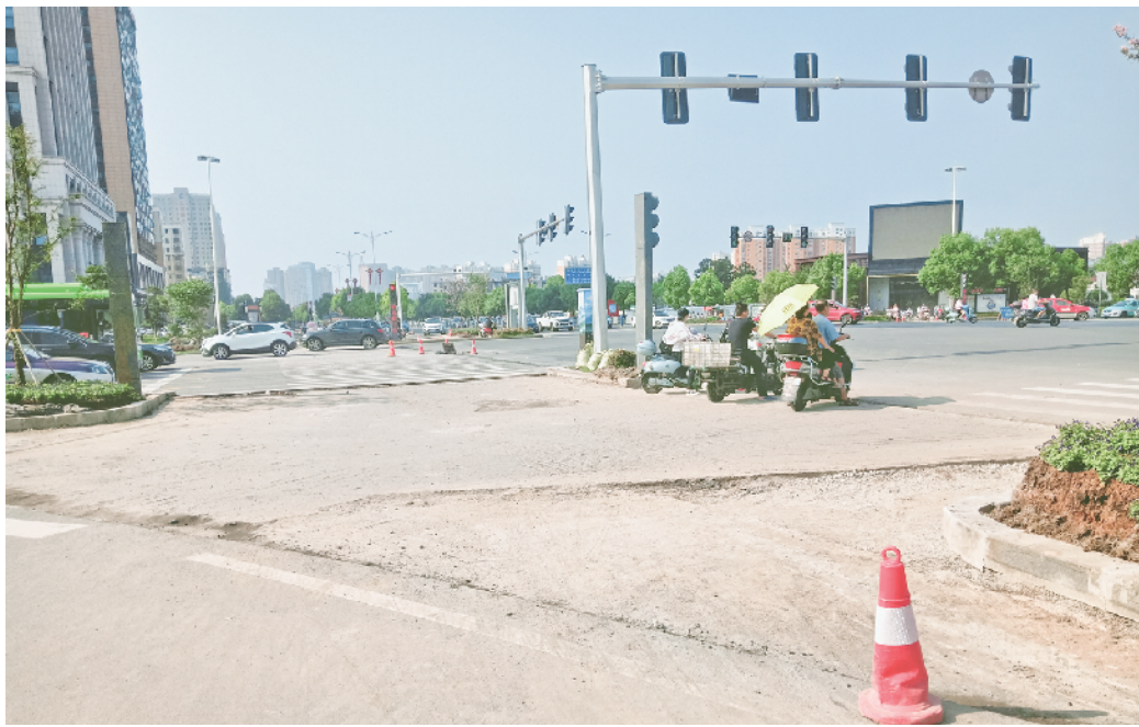
改造后待铺柏油的行人、非机动车等待区 本报记者 杨长喜 摄
