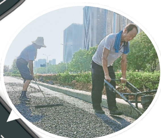
新拓宽路面柏油铺设中
