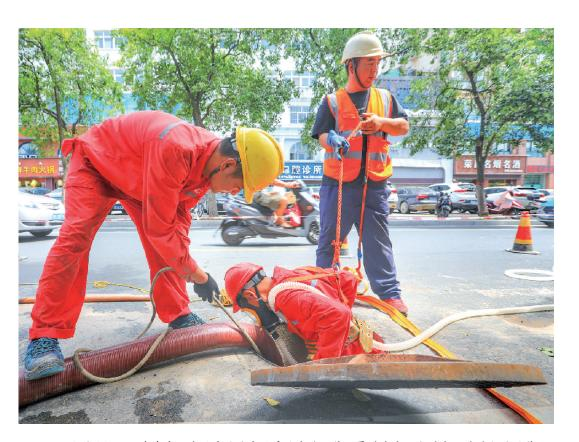
8月14日,记者在中心城区建设路东段看见市政工作人员对城市下水道交汇井进行疏通作业。据现场施工人员刘师傅介绍,这条街上的下水管道堵塞严重,打开井口几乎看不到污水流动的迹象。他们把长长的清洗胶管伸进下水道,利用高压冲洗,将管道的污泥集中到排污井內,然后再吸入到吸污罐车,直到见到井内比较畅通的水流。本次清淤工程从今年3月份开始预期年底前结束全市的水井管道清淤疏通。图为施工人员正在清淤。 本报记者 聂 品 摄
