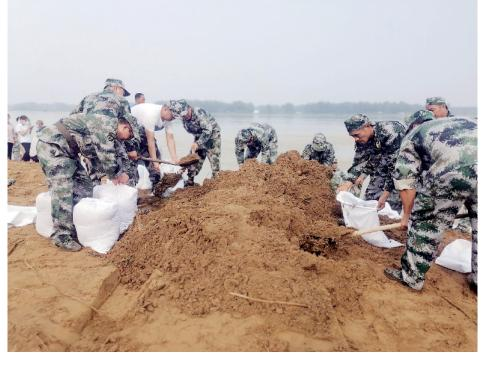
固始县沙河铺镇史 河段一处迎水坝即 将淹没,洪水直接 冲击史河大坝,百 余名抢险应急队伍 和居民紧急投入加 固堤坝中。截至目 前, 堤坝险情已基 本控制, 累计投入 人力 150 余人次, 编织袋 7500 余条, 挖掘机3台,铲车3 台,工程运输车21 辆,木桩200余根, 铁丝 200 余斤,塑 料布800平方米。
