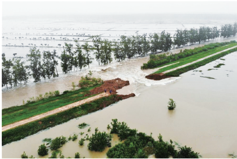
7月19日,洪水通过荒草三圩爆破口涌入蓄洪区内(无人机照片)。
