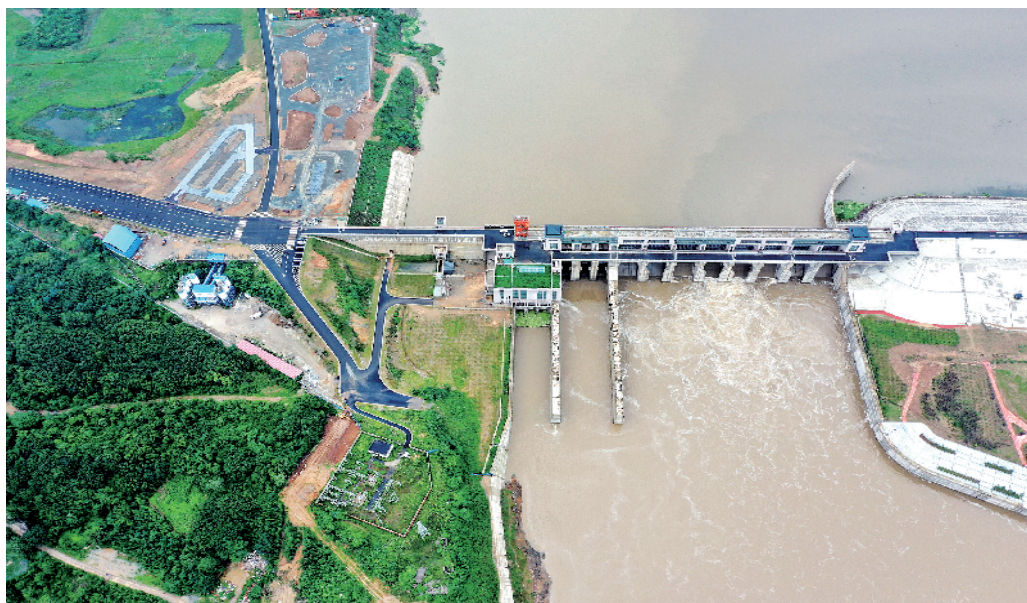
近日,由于淮河流域持续强降雨,7月18日,为减轻上游压力,根据省防汛指挥部要求,出山店水库开闸泄洪。 本报记者 郝光 摄
