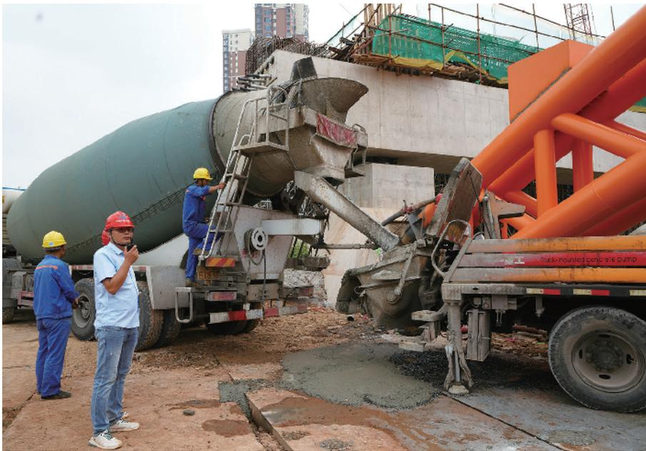
7月10日,由中铁大桥局承建的信阳市春晓路跨河拱桥拱肋钢管开始压注混凝土,为后续钢梁吊装奠定坚实基础。
