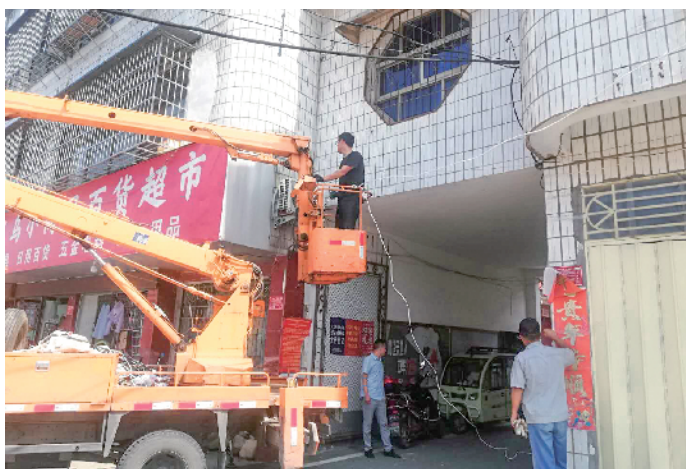
小区进行路灯安装 社区供图
