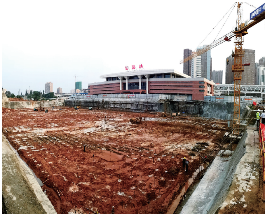
信阳火车站北广场改扩建工程总面积148.97亩,总建筑面积25000平方米,包括站前广场、地上地下停车场、人防工程和公交首末站等。图为该工程站前广场正在进行地下车库基坑支护作业。
