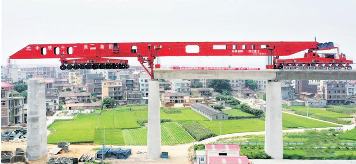
6月22日,中铁十一局集团建设者将一台1000吨箱梁架设在福厦高铁湄洲湾跨海大桥上,标志着我国首台1000吨级高铁箱梁运架一体机成功投入使用,我国高铁装备制造和施工水平获得重大突破。
