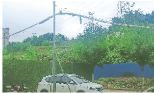
小区里的供水细管像电线一样挂在空中 本报记者 杨长喜 摄
