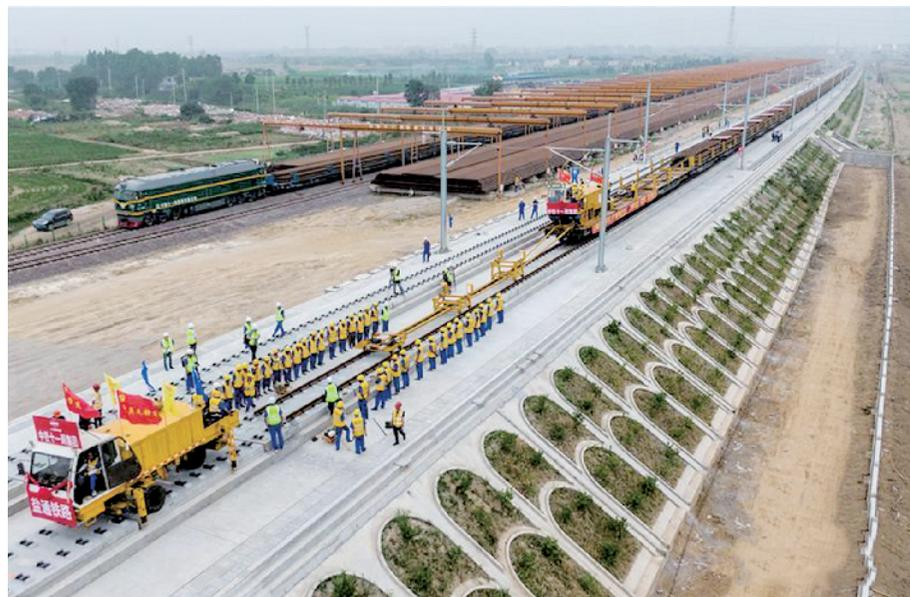
这是6月12日拍摄的盐通高铁东台站外铺轨施工现场。当日,在江苏省东台市的盐通高铁东台站外施工现场,一对500米长钢轨平稳落在无砟道床上,标志着盐通高铁建设进入线上轨道铺设阶段。盐通高铁位于江苏盐城、南通境内,是国家“八纵八横”高速铁路规划网的重要组成部分。
