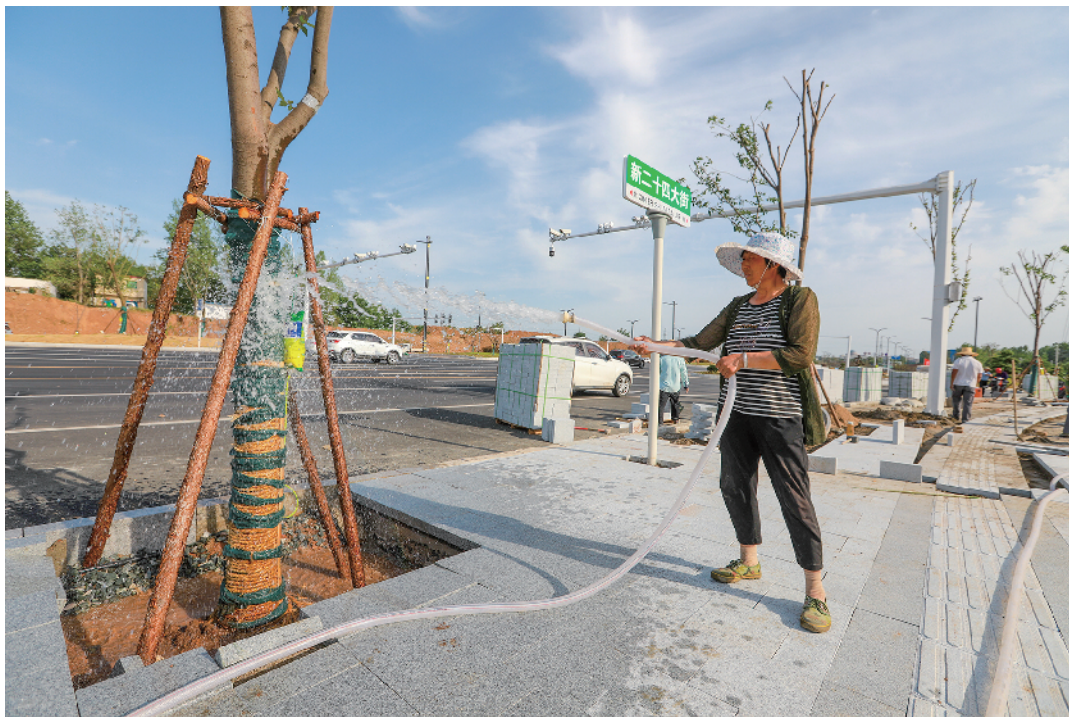
新二十四大街拓宽改造工程全长4.135公里,采用快车道与辅道分离、公交专用道、港湾式公交站台等,将原有路段进行加宽改造。如今的新二十四大街,既让群众享受到更加优质的城市生活,又成为展现信阳城市发展活力的一张亮丽的新名片。图为工作人员进行美化景观施工。
