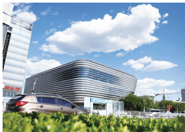
5月27日,作为2022年北京冬奥会训练场馆之一的国家体育总局冬季运动管理中心综合训练馆“冰坛”竣工,成为北京市今年第一个竣工的北京冬奥会新建场馆。据介绍,“冰坛”交付后将成为国家体育总局在京唯一的冬季冰上训练比赛基地,承担国家短道速滑和花样滑冰训练及科研任务。图为5月27日拍摄的国家体育总局冬季运动管理中心综合训练馆“冰坛”外景。
