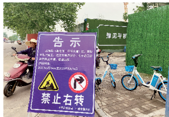
已经封闭施工的团结路 本报记者 李亚云 摄
