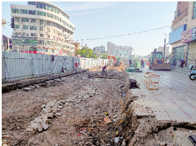
施工现场 本报记者 张方志 摄
