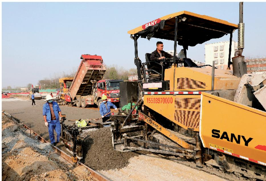
昨日,在市中心城区重点项目新二十四大街改扩建工程现场,工人们正在进行主路水泥砂浆铺设。连日来,随着我市建筑领域全产业链有序复工复产,各重点项目按下建设“快进键”,人员、设备、材料保障充足,多作业面统筹推进,确保民生工程早建成早惠民。
