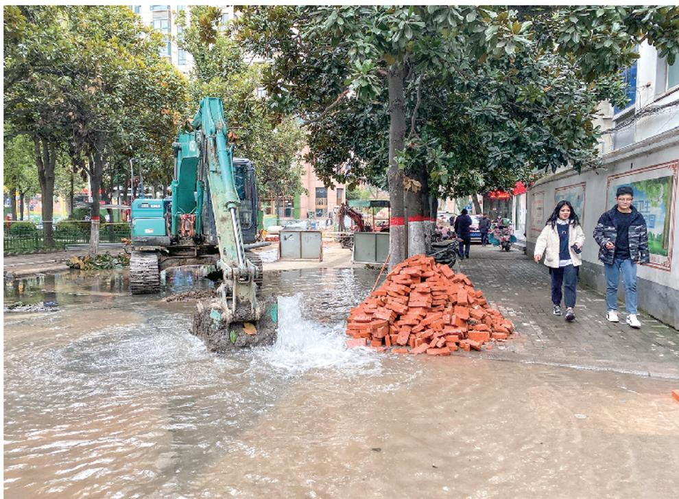
30日下午4时许,浉河区文化路南段污水管网施工现场自来水管道被挖断,大量清水涌出,淹没路面,给行人带来不便,并造成附近区域停水。市供水公司工作人员随后紧急抢修,尽量挽回损失。经过数小时努力,破损管道于当日晚上10时左右成功修复,并恢复正常供水。
