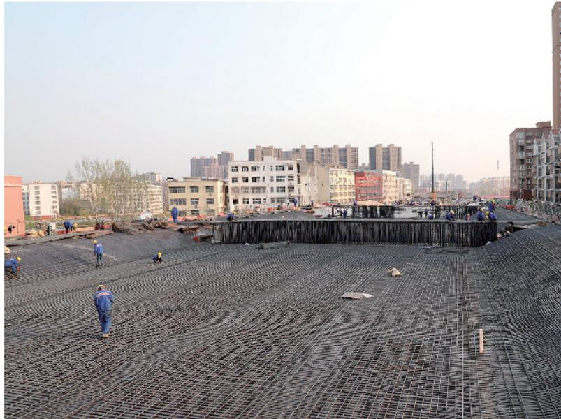
连日来,在中心城区重点项目新十八大街南段贯通工程高架桥施工现场,工人们忙着进行桥面钢筋混凝土作业。据了解,随着我市建筑领域全产业链有序复工复产,各重点项目按下建设“快捷键”,人员、设备、材料保障充足,多作业面统筹推进,确保民生工程早建成早惠民。
