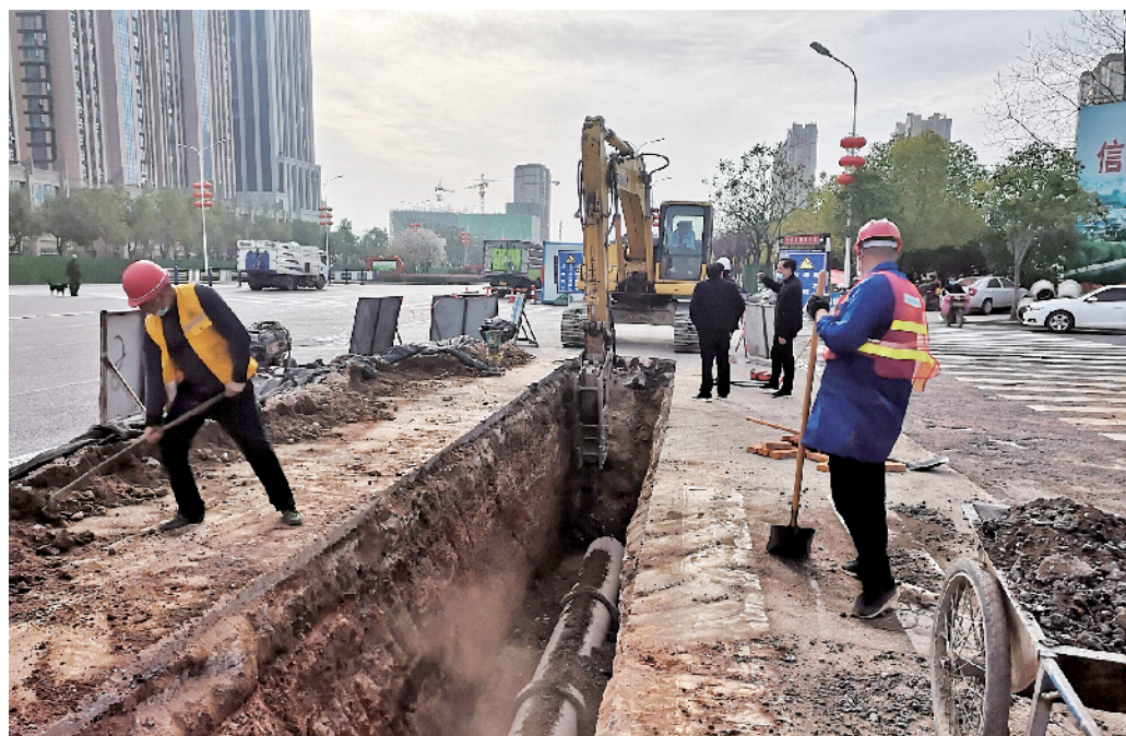
近日,为落实复工复产要求,推动城市基础设施建设,抢回施工工期。市城市管理局在做好疫情防控的基础上全力推进污水管网埋设施工,加快黑臭水体治理,创造良好的城市生活环境。 马涛 摄
