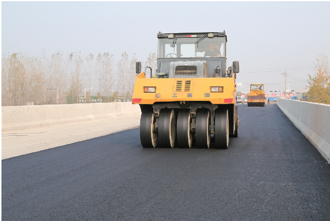
11月19日,在G328淮滨县淮河特大桥施工现场,桥面正在铺设沥青,全部工程即将完成,预计2020年元旦实现通车。据了解,淮河特大桥桥梁全长2976米,桥面宽16米,为双向四车道,建成后将是我省国道线上最长大桥。 杨德政 摄
