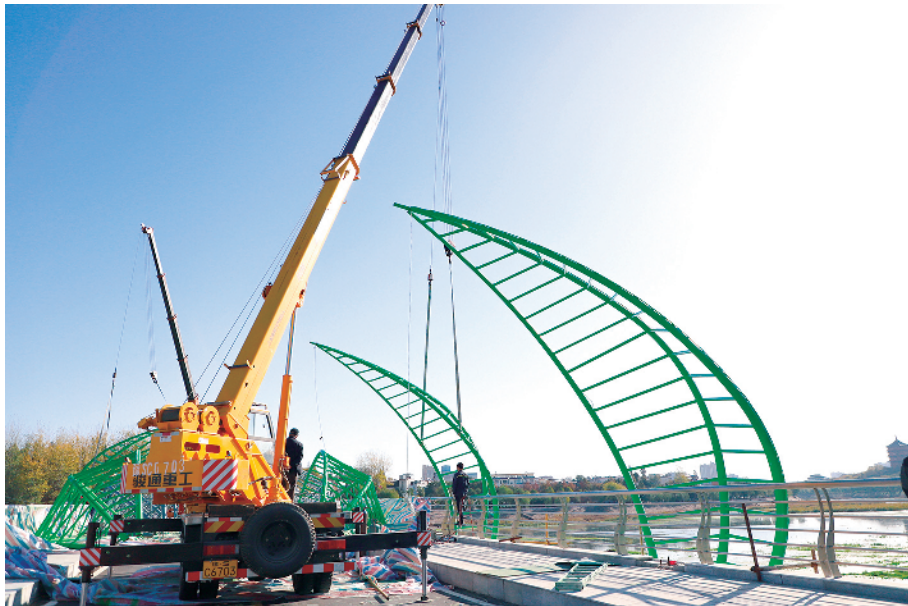
工人们正在安装肖家河桥景观灯 本报记者 张方志 摄
