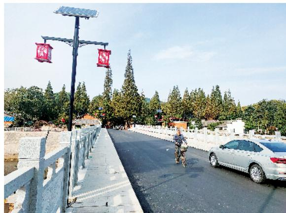
昨日上午,记者在浉河电站桥工程项目处看到,浉河电站桥已经全部竣工,桥面照明设施也已经建设完毕,桥面实现通行已经数日。据了解,浉河电站桥长66.12米,宽10米,桥面设计为双向两车道,桥梁荷载等级为公路Ⅱ级。该桥是南湾湖大坝以下连接浉河南北两岸的第一道桥梁,其建成通行对加强两岸往来有着重要意义。
