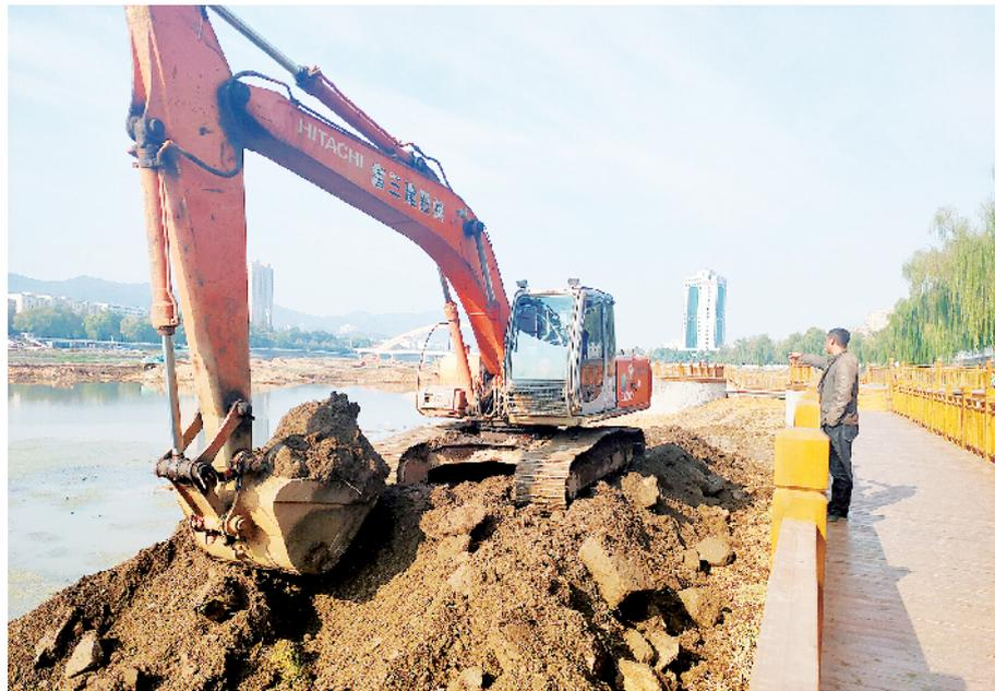
10月17日上午,浉河河道里清淤的挖掘机正在忙碌地施工。浉河关桥至虹桥清淤疏浚工程是浉河系统治理清淤疏浚工程的一部分,全长约800米,共需清淤11.6万立方米,工程完成后,将同其他工程一起使浉河防洪标准提高到50年一遇。据了解,该工程将于2019年12月31日前完成。
