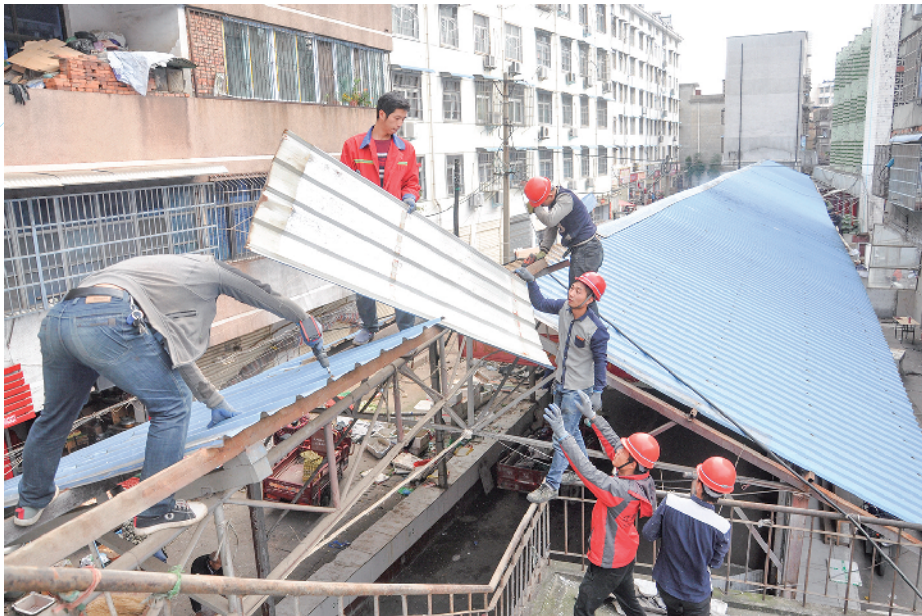
10 月 15 日,记者在四里棚农贸市场看到,现场拉起警戒线,工作人员值守两边,疏散周边群众;施工人员拆除违章建筑、清运建渣……拆违行动正火热进行。据了解,浉河区组织相关部门,联合对四里棚农贸市场违章建筑进行依法拆除,彻底消除安全隐患。图为拆违现场。
