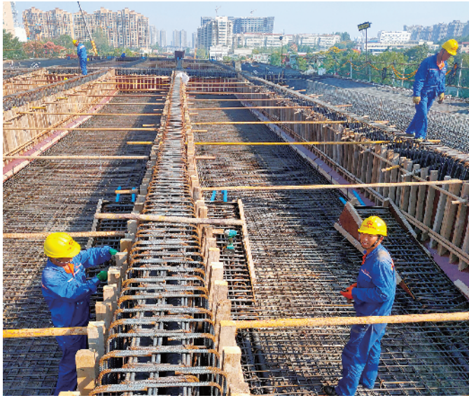
南京大道至平安大道段高架桥施工现场 本报记者 张方志 摄
