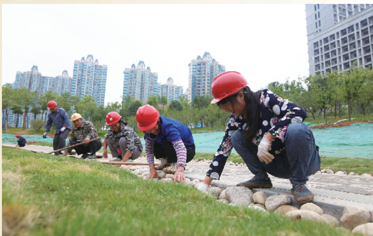
昨日,在羊山公园施工现场,工人们正在进行生态排水沟鹅卵石铺设。
